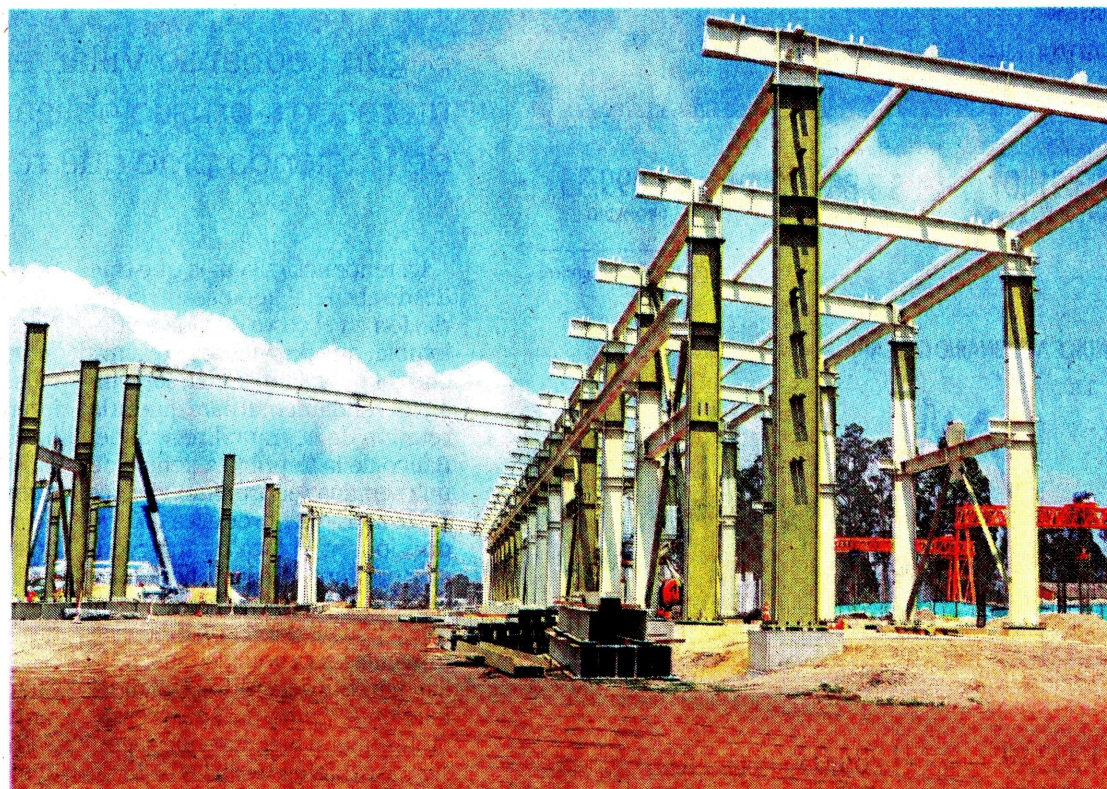
Sin licencia ambiental, las obras en corredor férreo no se han podido adelantar, pero se han hecho trabajos en el patiotaller El Corzo, en Facatativá. FOTO: EMPRESA FÉRREA REGIONAL (EFR)
