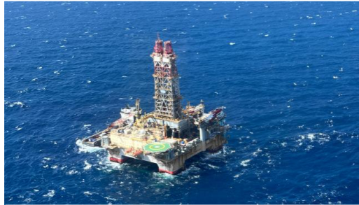
Pozo Orca Norte-1 Foto: Ecopetrol
