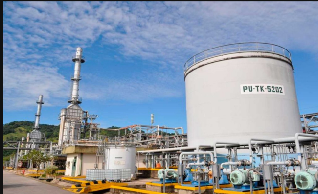
Planta de Cupiagua ampliará producción de combustibles
