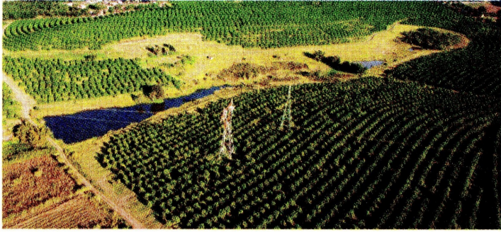
Infraestructura que se adapta a los ecosistemas/ISA.
