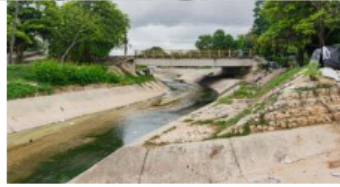
Instalan 50 geobags, para contener corrientes de arroyo El Platanal en Soledad
