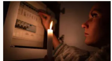
Ecuador sin luz: apagón a nivel nacional por fallas en línea de transmisión
