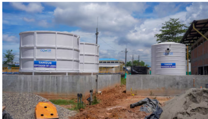
La Planta de Tratamiento de Lodos de Barrancabermeja sería entregada en abril de 2025. (Suministrada / VANGUARDIA)
