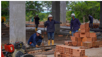
La Planta de Tratamiento de Lodos de Barrancabermeja sería entregada en abril de 2025. (Suministrada / VANGUARDIA)
