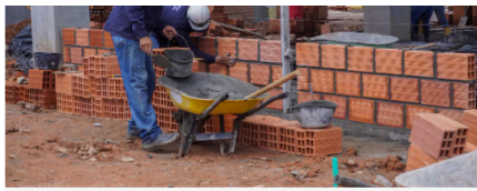
La Planta de Tratamiento de Lodos de Barrancabermeja sería entregada en abril de 2025. (Suministrada / VANGUARDIA)
