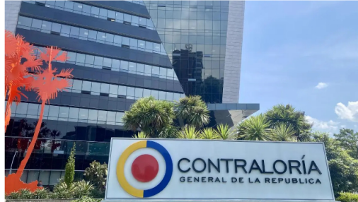
Fachada Contraloría General de la República
