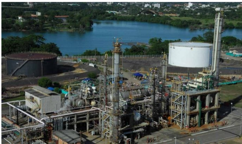
Ecopetrol inició mantenimientos a la refinería de Barrancabermeja. Imagen: Ecopetrol
