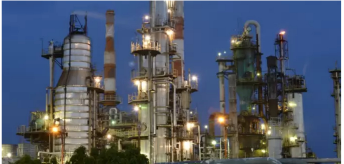
Refinería Ecopetrol Barrancabermeja
