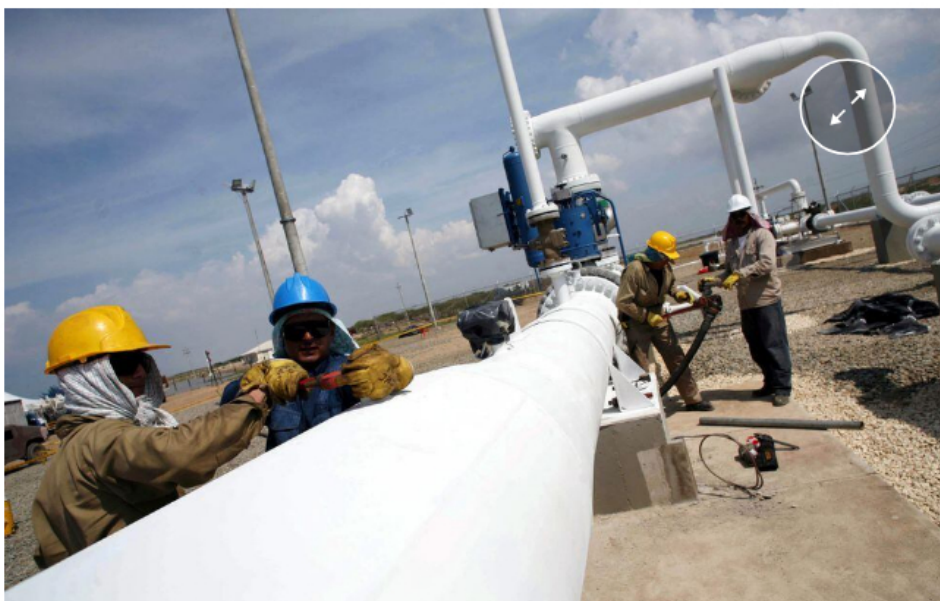
Trabajadores en Manaure (Colombia) ajustan una válvula del gasoducto que conecta con Venezuela, en 2007, un día antes de su inauguración.
