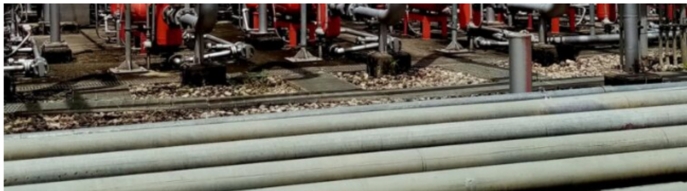
Anoche técnicos Ecopetrol iniciaron el mantenimiento al CPE, Facultad Central de Procesamiento de Cupiagua, instalado en el área rural de Aguazul, Casanare. Foto: Archivo particular.
