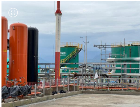
Bloque CPO-09, ubicado en el departamento del Meta. FOTO:ECOPETROL
