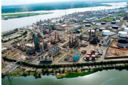
Refinería de Barrancabermeja
