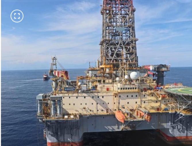
Pozo Sirius-2 de Ecopetrol y Petrobras FOTO: ECOPETROL
