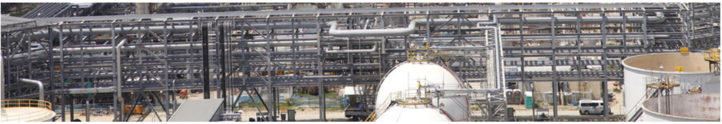
La obra comenzó con un presupuesto de 3.777 millones de dólares y terminó costando 8.016 millones de dólares. Crédito: Colprensa.
