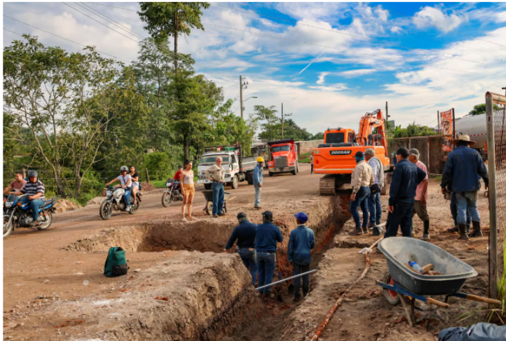
Obras de pavimentación entre Boston y Vía Yuma en Barrancabermeja (Fotos suministradas por Ecopetrol / VANGUARDIA)
