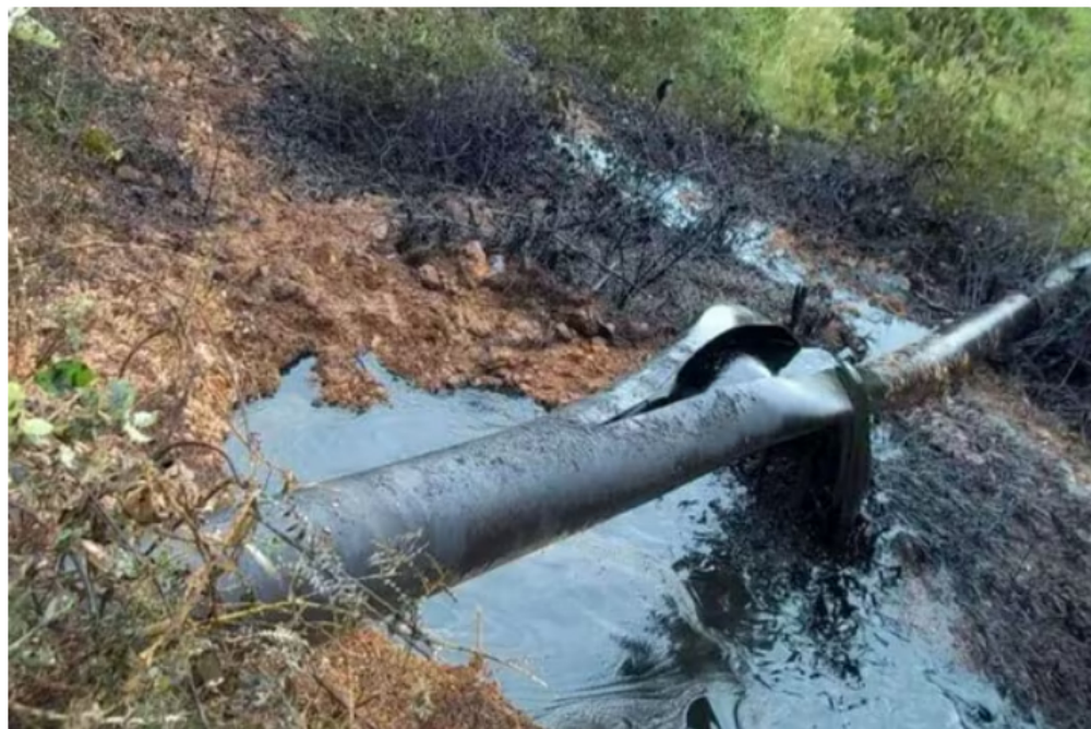
La afectación al Caño Limón Coveñas ocurrió el pasado 7 de agosto por presuntos trabajadores de Ecopetrol - crédito EFE
