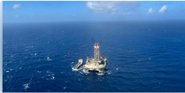
Plataforma de perforación de Uchuva 2 © Ecopetrol
