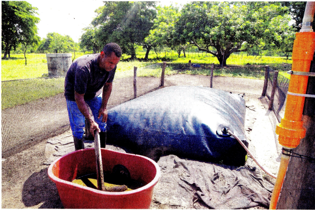
Todos los días, a la mañana, Elkin Palacin alimenta el biodigestor que es esencialmente una "bolsa de plástico" gigante que recibe el estiércol y posteriormente entrega gas metano a través de unos tubos conectados a la cocina. FOTOS: C.R.A.
