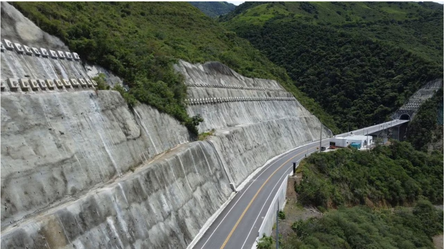
Instalan nuevo peaje en importante vía de Colombia. | Foto: Suministrada a SEMANA.
