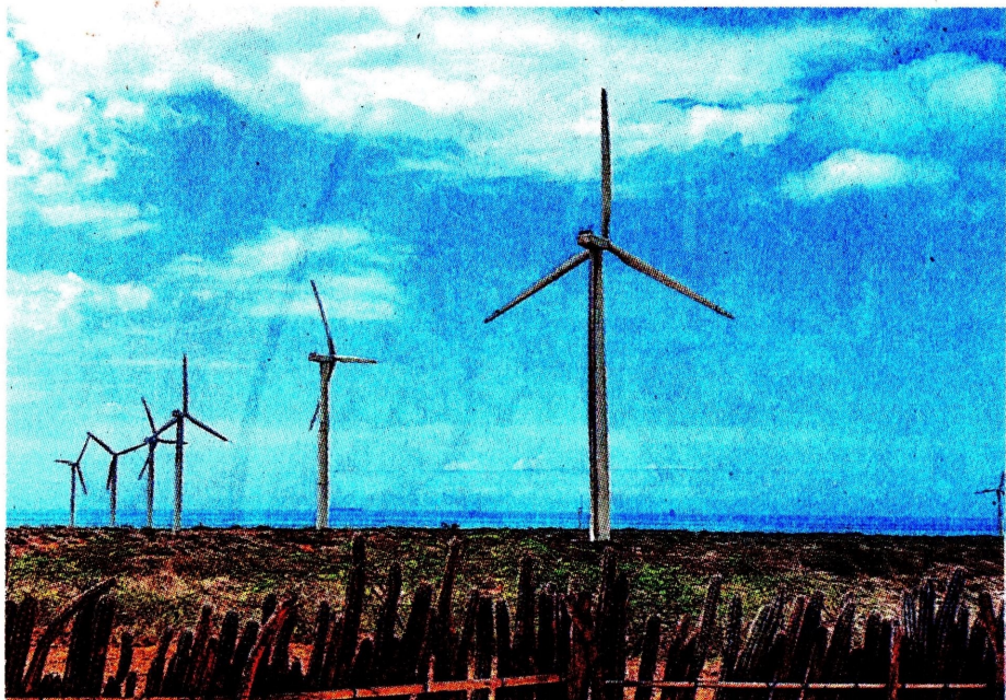
El parque eólico Jepirachi ha generado 978.26 gigavatios por hora a través de 15 aerogeneradores de 1,3 MW cada uno. Los vientos alisios que soplan en este territorio tienen una velocidad de 9.8 metros por segundo. FOTO: CORTESÍA EPM
