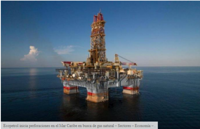
Ecopetrol inicia perforaciones en el Mar Caribe en busca de gas natural – Sectores – Economía –
