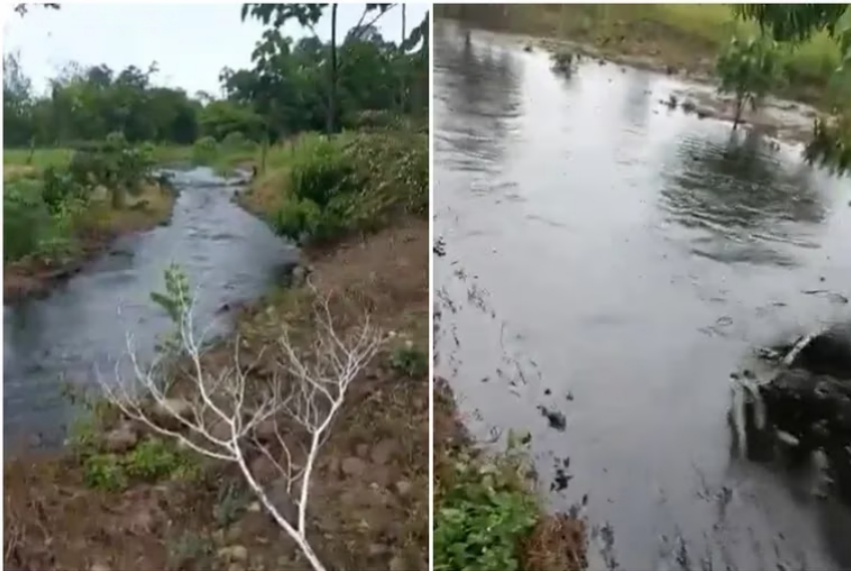
El oleoducto Caño Limón Coveñas volvió a sufrir un ataque en su estructura, en el tramo que pasa por la vereda La Pava de Saravena (Arauca).
