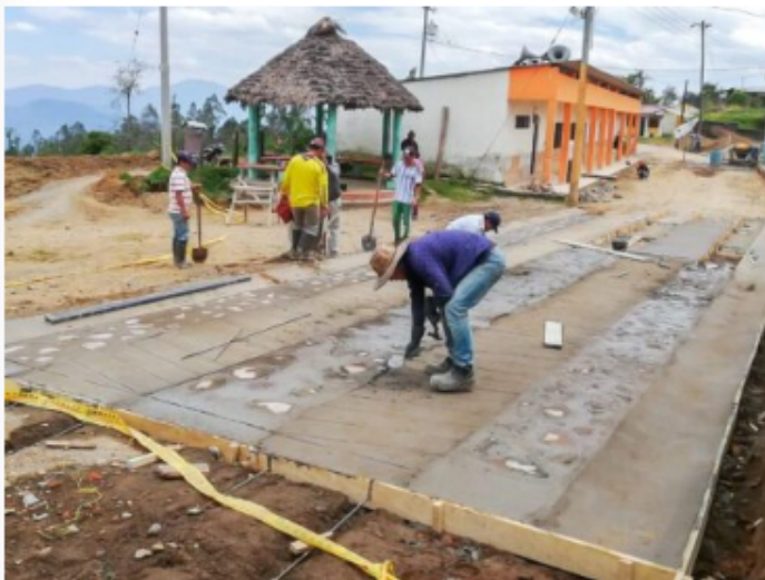
Construyeron placa huella en Santa Bárbara, Sandoná
