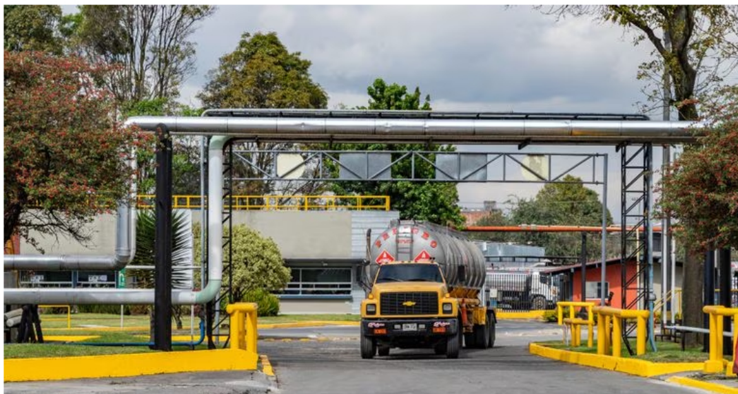
Carro tanque entrando al terminal de abastecimiento de combustibles de Primax en Puente Aranda, Bogotá. - Foto: Primax
