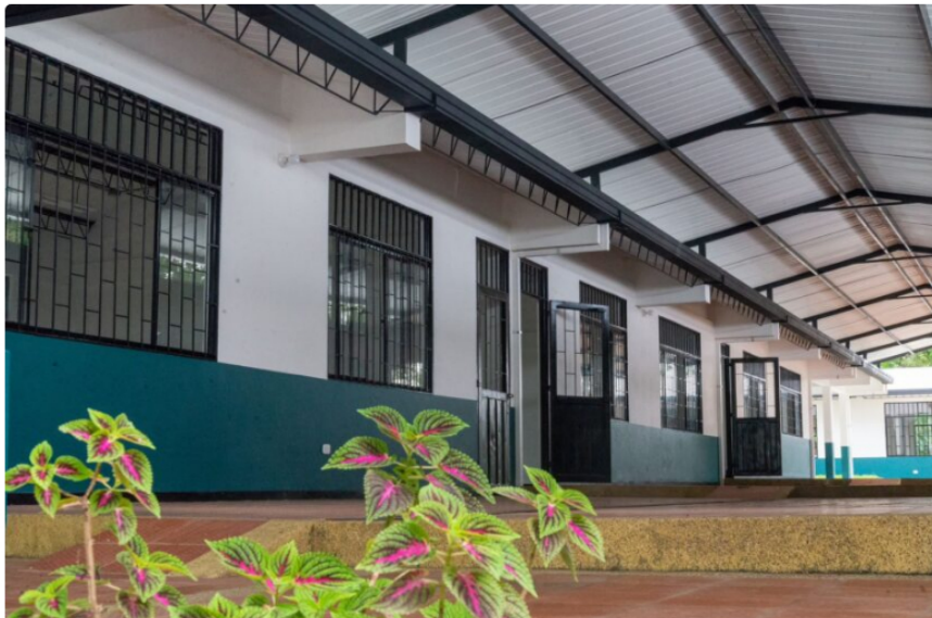
Ecopetrol entregó primeras obras de mejoramiento de la I.E. San Isidro de Chichimene
