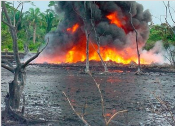
Oleoducto Caño Limón-Coveñas de Ecopetrol atacado por el ELN
