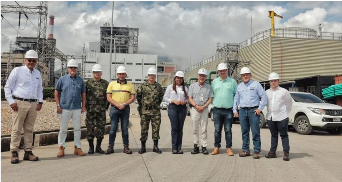
Esta planta solar se oficializó con autoridades locales y regionales. - Foto: Alcaldía de Cúcuta
