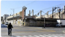
Cierre de vías desde este martes por demolición del antiguo Cinema Murillo
