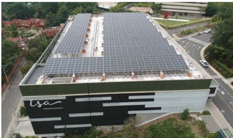
Interconexión Eléctrica (ISA). Imagen: ISA
