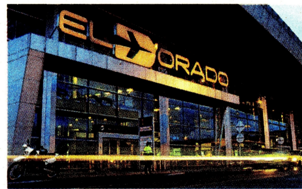
Con el uso de la energía solar, el Dorado ha ahorrado 9,2 millones de kWh de energía convencional. Foto: archivo ET.
