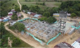
Avanza la construcción de colegio en el corregimiento Ciénaga del Opón
