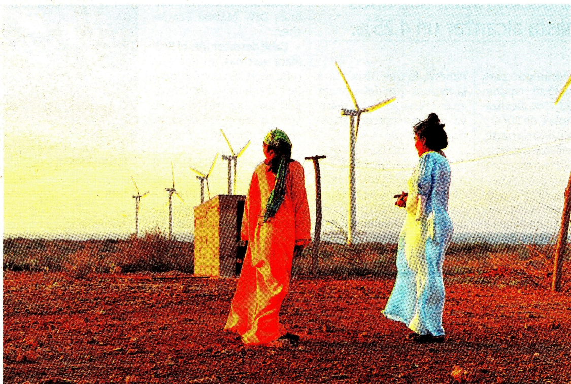
El parque está cercano a cumplir 20 años de operación y tiene dos de las 15 turbinas fuera de servicio. Cortesía EPM
