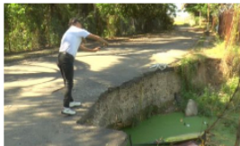
Presidente JAC barrio La Libertad denuncia retraso en inicio de obras de la carrera 20
