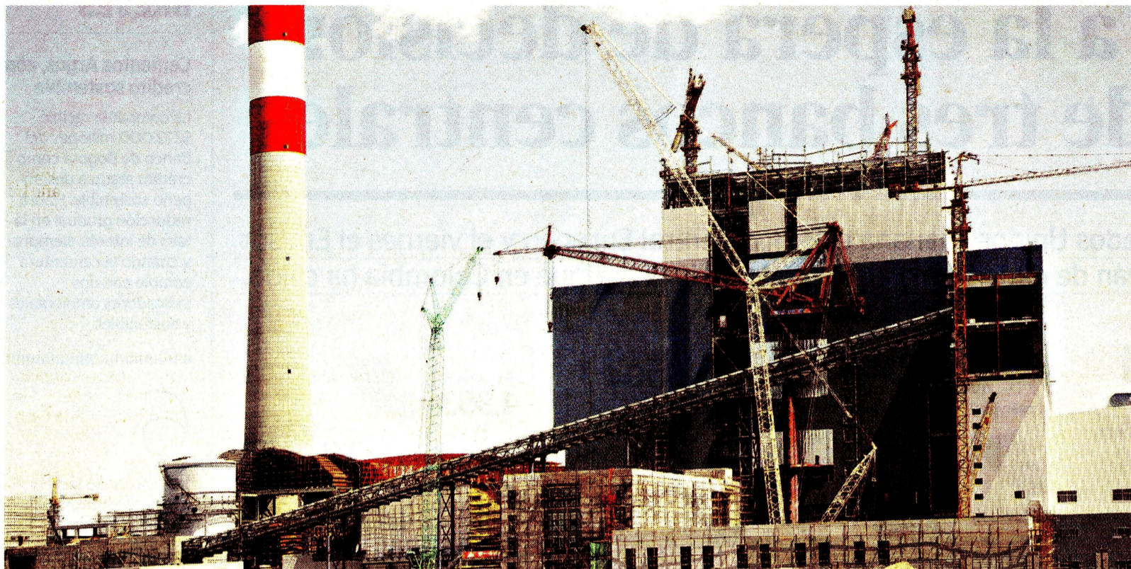
El sector termoelectrico está comprometido con las comunidades del área de influencia de las centrales de generación para mejorar su calidad de vida. Archivo
