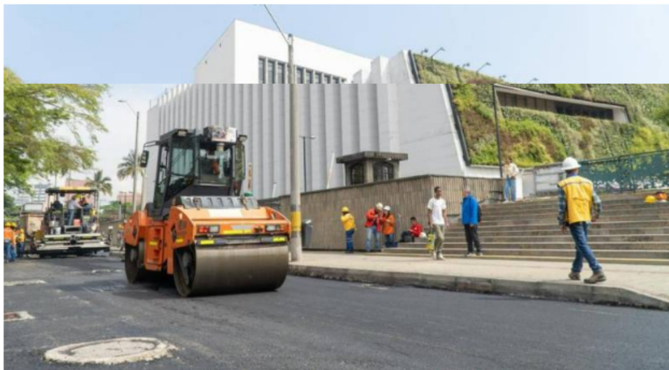
Pavimentación en el centro de Medellín, en la mezcla se empleó el equivalente a 200.000 tapas de bebidas. FOTO CORTESÍA
