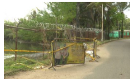
Inician obras para mitigar socavación en vía posterior al Club Infantas
