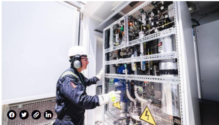
El electrolizador ubicado en la Refinería de Cartagena que genera hidrógeno.
