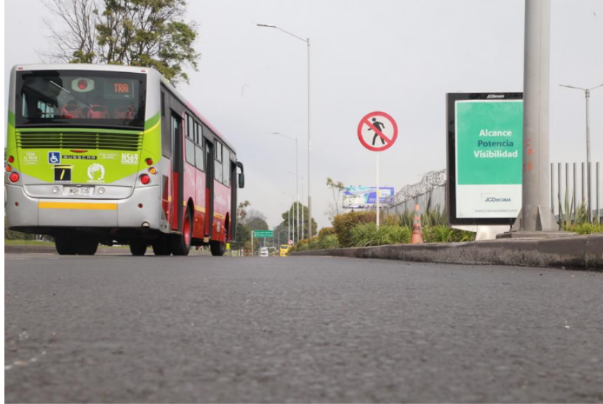
Grupo Ecopetrol y Aeropuerto El Dorado inauguran primer tramo vial pavimentado con plástico reciclado - Foto: Ecopetrol
