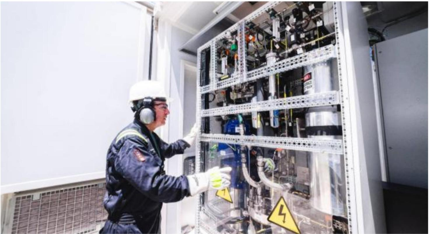
El electrolizador ubicado en la Refinería de Cartagena que genera hidrógeno.
