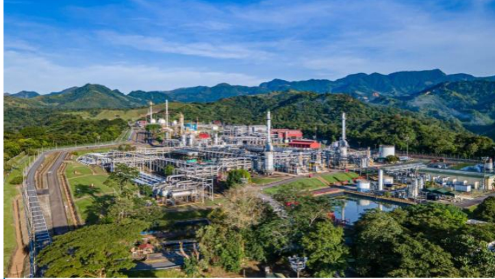
Planta de gas Cupiagua de Ecopetrol
