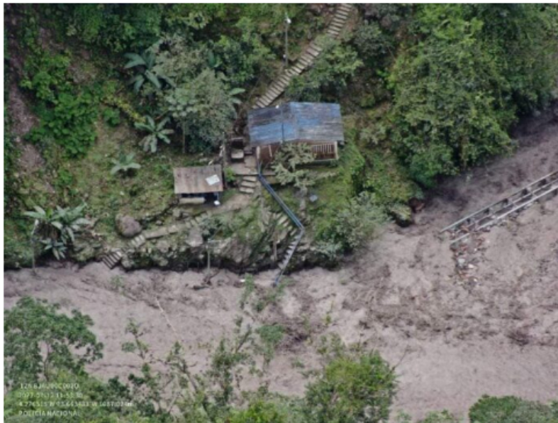
Bocatoma Quebrada la Honda, acueducto de Villavicencio.
