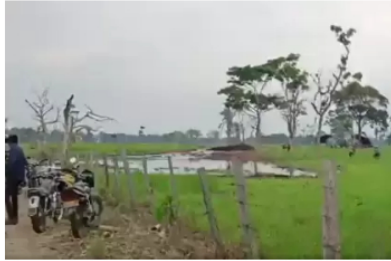
Nuevo atentado contra oleoducto Caño Limón Coveñas en Saravena generó derramamiento de crudo
