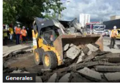
Generales Procuraduría investiga a exalcaldesa de Cartagena por posibles irregularidades en contratación de obras que superan los $ 20 mil millones
