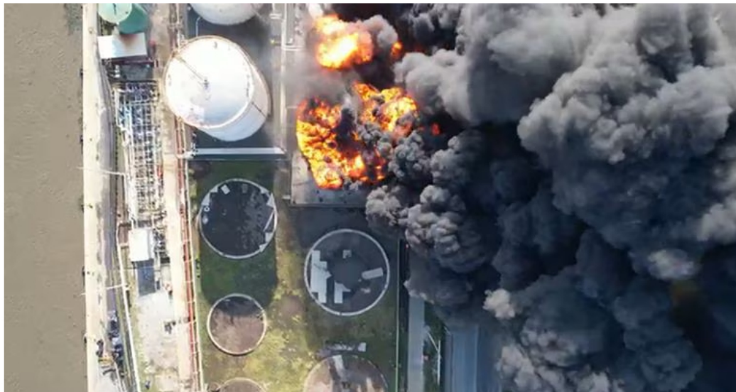
Incendio en el Puerto de Barranquilla. - Foto: Cortesía: API.
