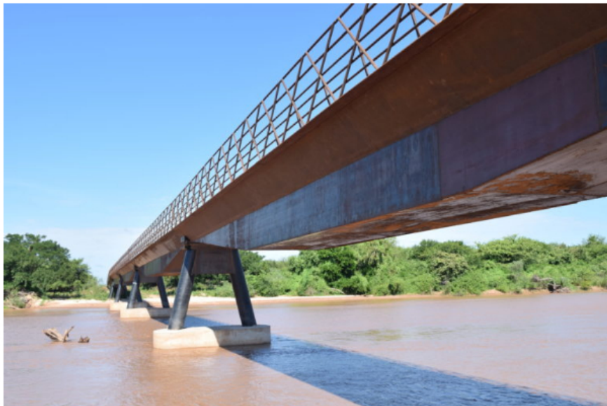
Según los menonitas, la construcción del puente demoró un año y fue concluida en octubre de 2021. Foto: Iván Paredes Tamayo.
