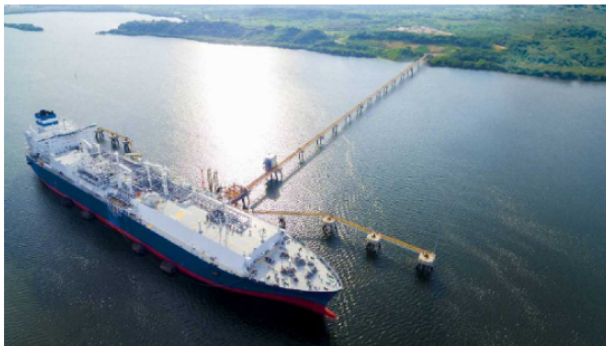
La Planta de Regasificación del Pacífico debe entrar en operación en 2028. - Foto: SPMC
