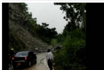
De nuevo, cierre en la vía Bucaramanga-Matanza
