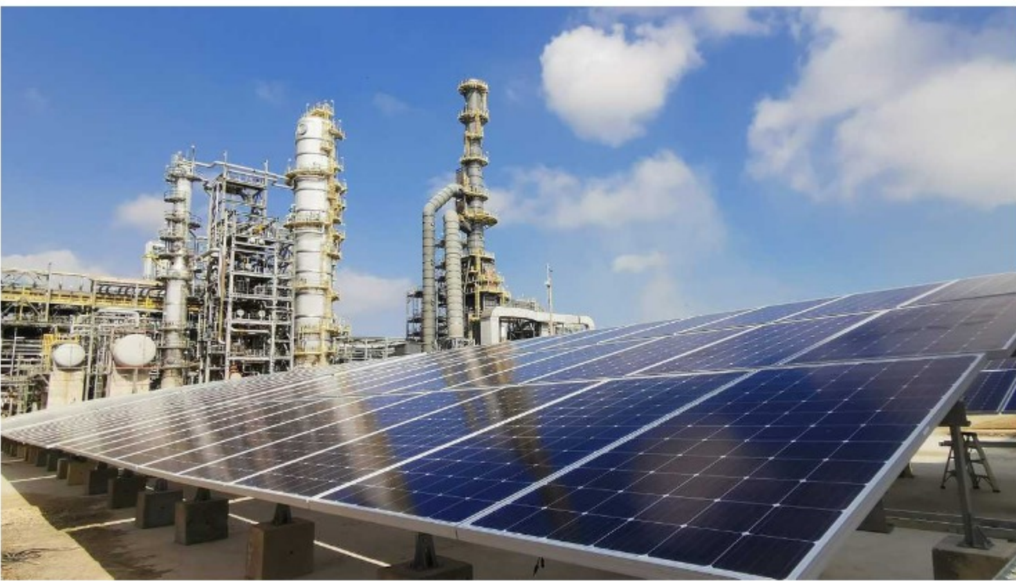
[redacted] inauguró el 18 de marzo en [redacted] su primer proyecto de hidrógeno verde. - Foto: Foto: [redacted]
